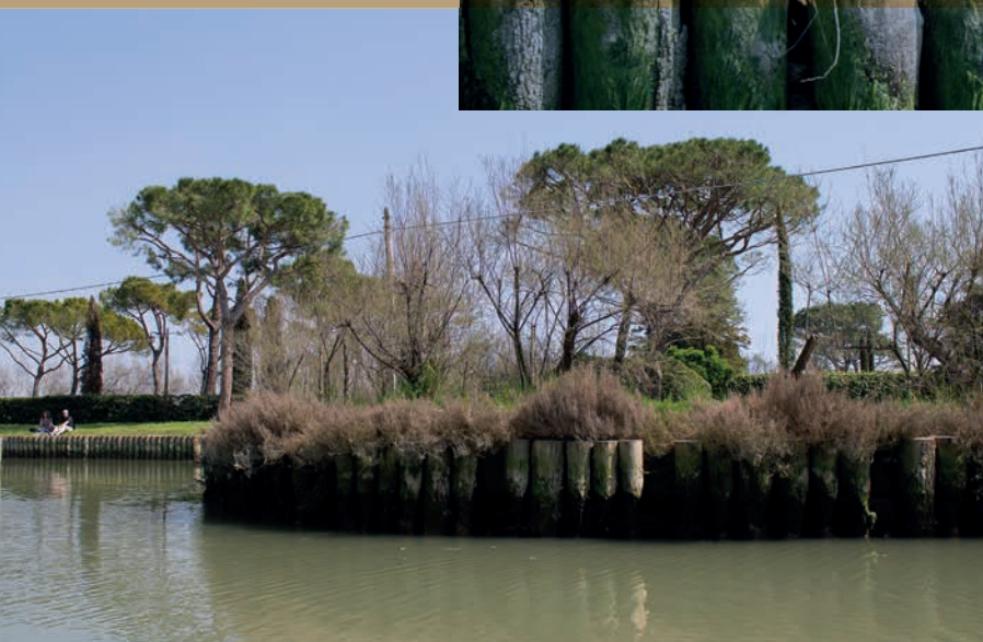
Incrocio di canali e rive in legno
